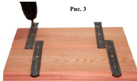
1. Для удобства монтажа на тыльной стороне доски карандашом отмечается вертикальная линия в местах предполагаемого соединения доски с направляющими.
